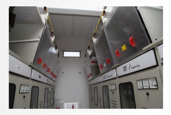
In vielen Altanlagen in offener Bauweise fehlen oftmals die erforderlichen Möglichkeiten zum Erfüllen der Schutzmaßnahmen nach DIN VDE 0100 Teil 100 (5 Sicherheitsregeln) und hier häufig für die Regel 5 (Benachbarte und unter Spannung stehende Teile Abdecken oder Abschranken)
